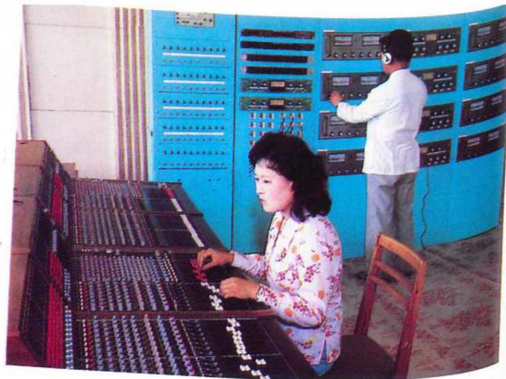
Acoustic control room La cabine de contrôle des sons.
