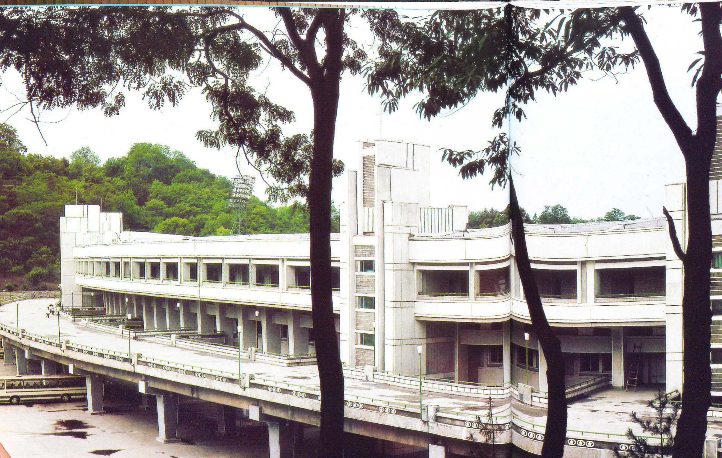
An elevated road linked with the stadium Le saut de mouton appliqué aux entrées du stade.
