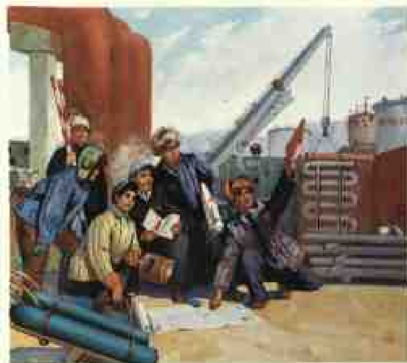
⑥ 鞍钢宪法作指南，群策群力建泵站，三结合来绘蓝图，机泵轰鸣卷巨澜。
